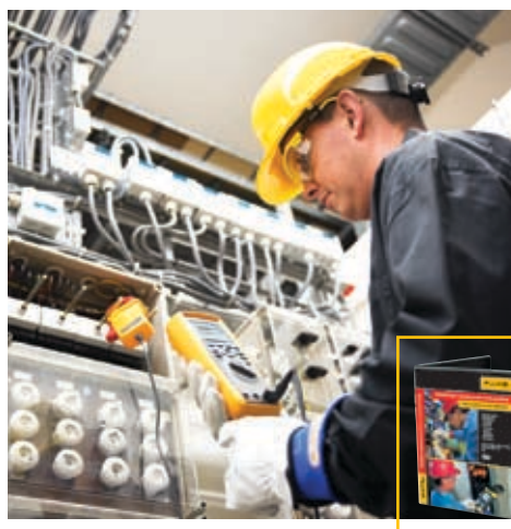
Utilizzate attrezzature di protezione, come ad esempio occhiali di protezione e guanti isolanti.
